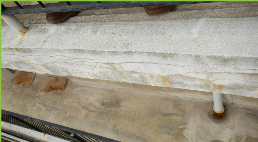
Figur 8: Vandrette revner i forkant, som indikerer, at betonen er delamineret. Der ses desuden hvide og brunlige udfældninger fra revnerne, som indikerer, at der foregår en fugttransport i revnerne. Delamineringer kan dog også optræde uden det giver sig udtryk i form af revner i forkanten. Derudover er mange altaner udført med rækværk eller brystninger, der skjuler altanernes forkanter, hvormed eventuel revnedannelse i forkanten vil være skjult.
