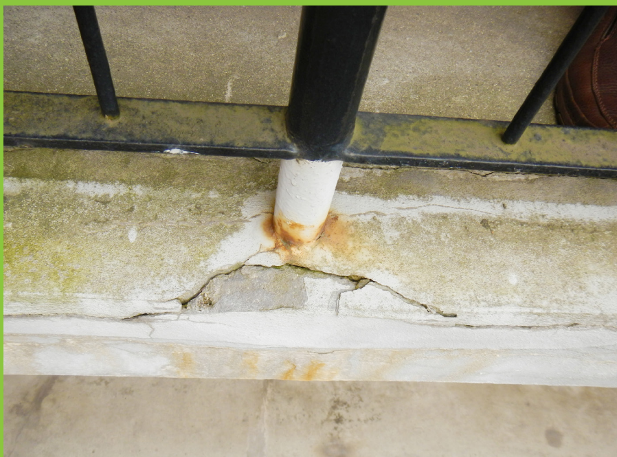
Figur 10: Revner og rødbrune udfældninger omkring scepterfæste til rækværk indikerer, at der foregår korrosion på rækværkets fastgørelse i betonen. Rækværkets bæreevne kan være reduceret som følge heraf.
