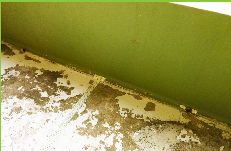
Figur 19: Øverst: Drypnæse (markeret på foto) ved forkant som i dette tilfælde er "indstøbt" i betonen. Drypnæsen sørger for at overfladevand drypper af ved altanens forkant og reducerer opfugtningen af altanens underside. Nederst: Udslidt/defekt belægning på overside af altan medfører øget opfugtning af betonen.
