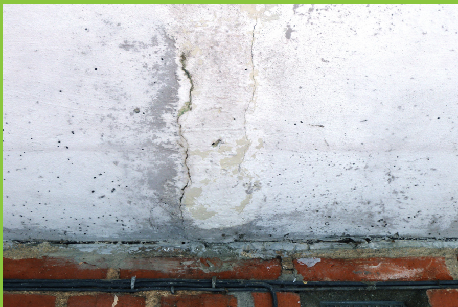
Figur 13: Altan med udliggerjern, hvor der ses revner og opbuling i undersiden, som er orienteret vinkelret på facaden. I dette tilfælde er revnen opstået som følge af korrosion på et overliggende udliggerjern. Denne type revner og udbulinger kan både optræde i altanens over- og underside afhængigt af, hvor på udliggerjernet korrosionen foregår. Bemærk at der ikke ses rødbrune udfældninger i forbindelse med revnen, selvom der foregår korrosion, fordi der ikke er en fugtgennemsvivning i altanpladen, der fører rustudfældninger med til undersiden.
