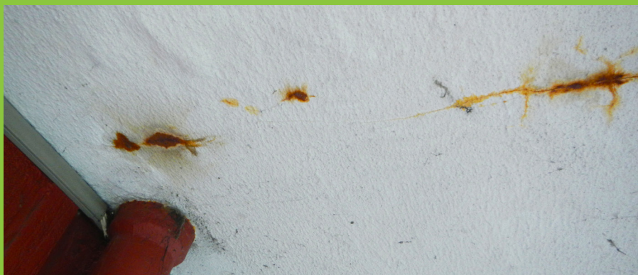
Figur 6: Revne i underside af altandæk med rødbrune udfældninger, hvilket giver en klar indikation på, at armeringskorrosion foregår.
