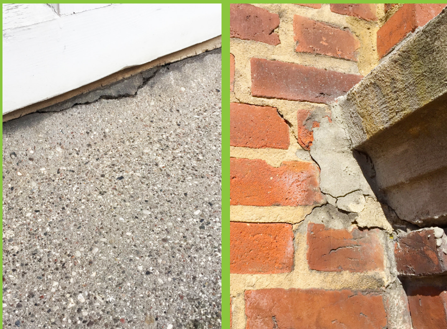
Figur 12: Venstre: Revne i hulkehl under terrassedør. Hulkehlen har normalt til formål at lede vand væk fra samlingen mod facaden, men hulkehlens funktion vil her lokalt være forringet. Højre: Revner i mørtelfuger i område, hvor altanplade møder facade, giver øget adgang for fugt til udliggerjern, hvilket kan være medvirkende til at initiere korrosion på jernene.
