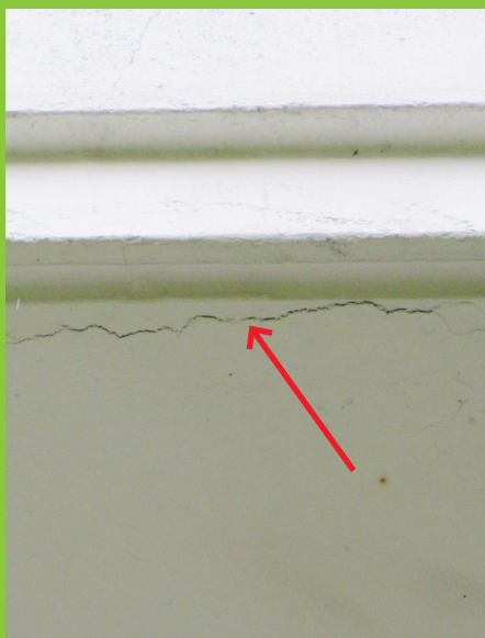
Figur 5: Venstre: Underside af altan med revne/begyndende afskalning parallelt med den langsgående armering i forkant. Revnen er her opstået pga. korrosion på det langsgående armeringsjern i forkanten. Bemærk at der ikke observeres rustfarvede udfældninger i forbindelse med revnen. Højre: Underside af altan med afskalninger over tværgående armering ved forkant. Disse afskalninger er startet som revner og har siden udviklet sig til regulære dæklagsafskalninger.
