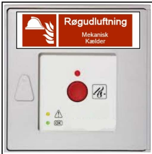
Figur 05.11.05: Eksempel på aktiveringstryk for røgudluftning
