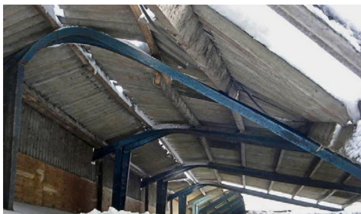
Figur 3 Kipning nær rammehjørne i en stålrammebygning under stor lodret last. Kipningsfastholdelsen har været mangelfuld.
