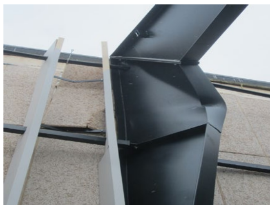
Figur 3 Kipning nær rammehjørne i en stålrammebygning under stor lodret last. Kipningsfastholdelsen har været mangelfuld.
