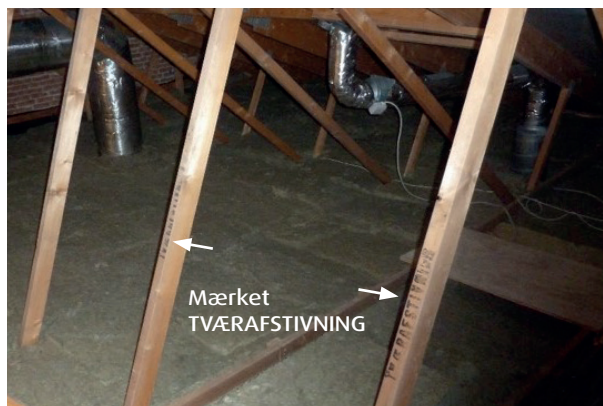
Figur 10 Gitterstænger, som er mærket TVÆRAFSTIVNING, der dog ikke er udført. Foto: Arne Elkær A/S.
