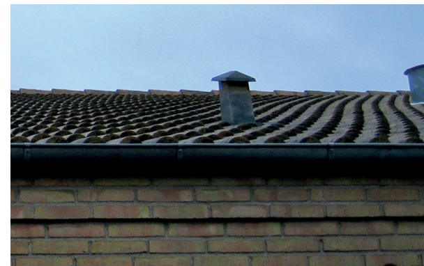
Figur 14 Tagsten der ligger i S-form, som afspejler spærhovedernes form.
