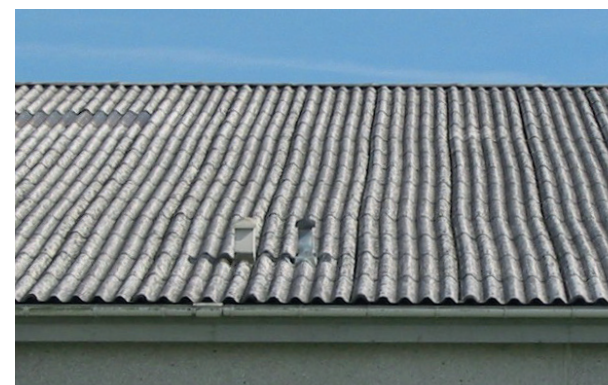
Figur 15 Tagplader, der ligger i S-form, skyldes ofte at gitterstængerne ikke er afstivet eller at skråafstivningen af dem mangler.
