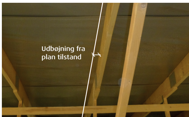
Figur 7 Spærhoved, der bøjer ud fra plan tilstand. Den hvide streg markerer den ikke-udbøjede tilstand. Foto: Arne Elkær A/S.
