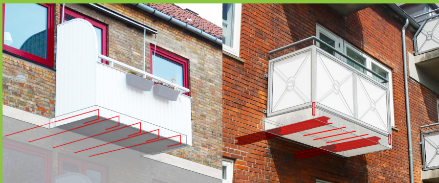
Figur 1: Den primære bærende funktion i en udkraget altanplade kan både være udgjort af indstøbte armeringsjern, som er ført med ud i altanpladen fra etagedækket (tv.) eller af omstøbte stålprofiler (udliggerjern), der er fastgjort til bjælkelaget (th.).
