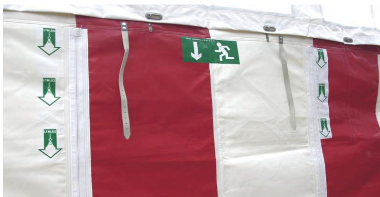
Figur 6. Mærkning af udgang og lynlås.
